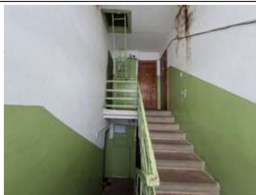
2.stāva kāpņu telpa
