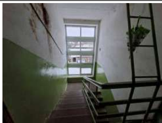
2.stāva kāpņu telpa
