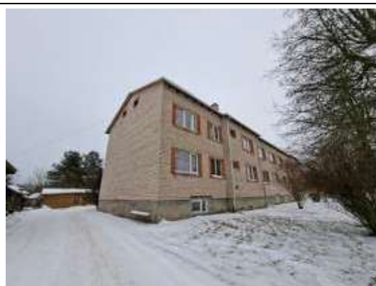
Dzīvojamā māja Stacijas ielā 16
