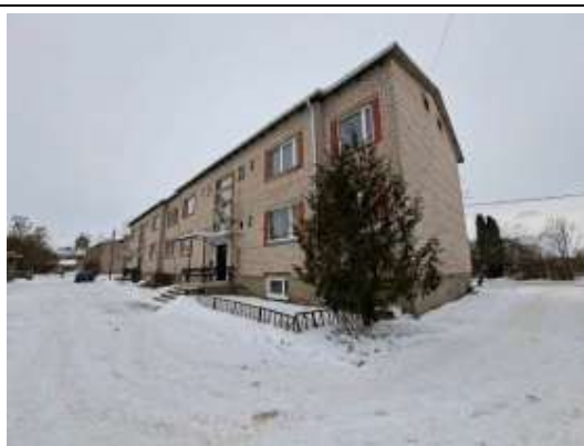
Dzīvojamā māja Stacijas ielā 16
